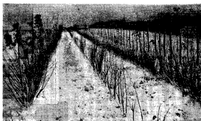
Рис. 2. Опытная посевная снегозащитная полоса на автомобильной дороге Москва — Куйбышев с однолетними всходами (слева) и в трехлетнем возрасте (справа)
