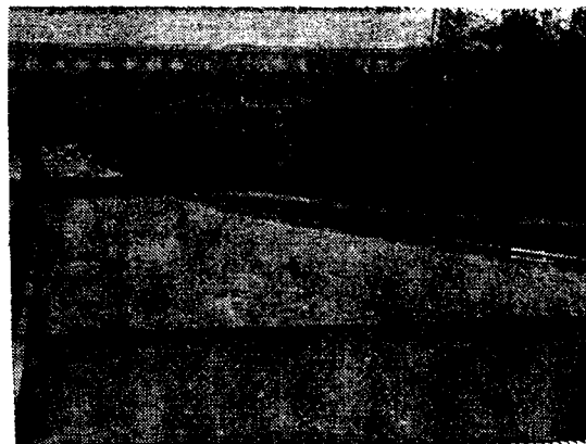
Рис. 4. Светлая поверхность асфальтобетонного покрытия на щебне «дорсил»
