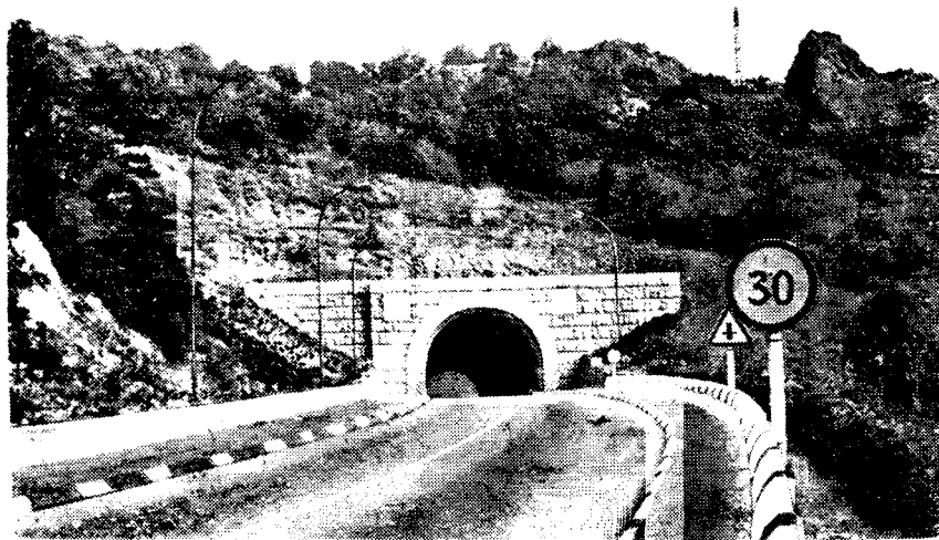
Удачное устройство короткого тоннеля в оползневом районе на дороге Ялта — Севастополь позволило по сравнению с устройством выемки значительно повысить транспортно-эксплуатационные качества этого участка дороги, сохранить существующие ландшафт и рельеф
