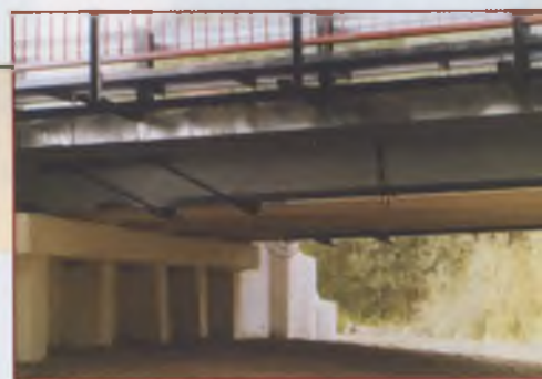
Мост через реку Можайку, г. Мосальск. Вид наклеенной арматуры на балках пролетного строения выше металлоконструкций консольных тротуаров
