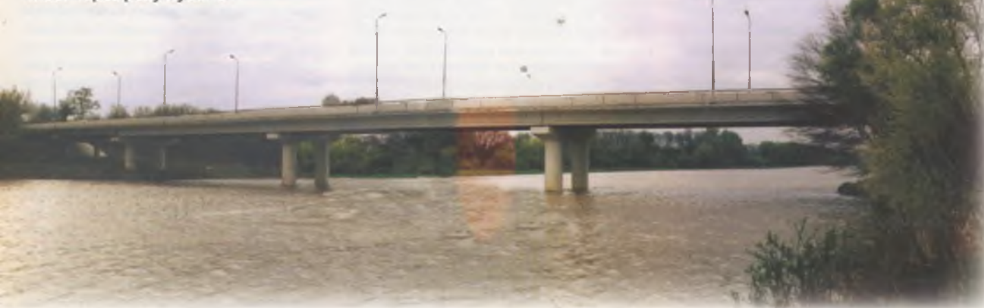
Мост через реку Кубань
