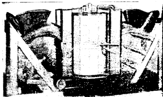
Рис. 5. Намотанный сердечник в процессе сборки трансформатора.
