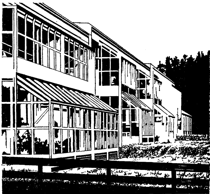
Рис. 124. Жилой массив Таберг, в котором для каждой квартиры предусмотрена застекленная веранда (фото Бенгта Хидемарка и Арне Бойсена)
