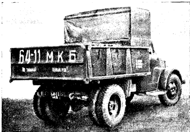
Рис. 3. Автомашина ГАЗ-93, переоборудованная для перевозки пищевых отходов общественного питания.
