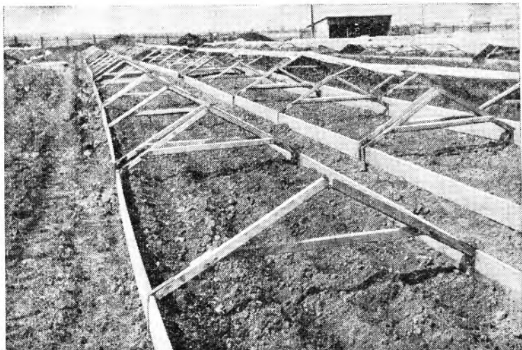
Рис. 8. Ленточная расстановка УРП на участке.
