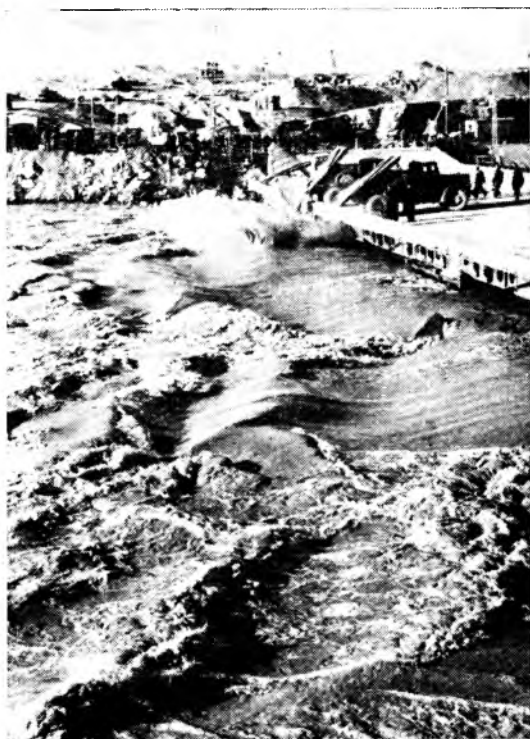
Идет перекрытие Сырдарьи
