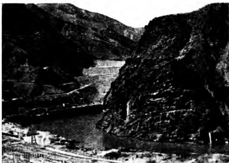
Строительство плотины Нурекской ГЭС. (Фото автора)
