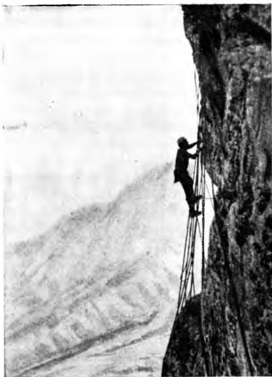
На строительстве плотин в горах работают и скалолазы. (Фото автора)
