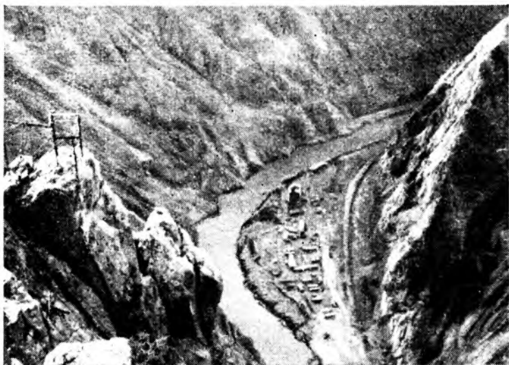
Нарын в месте строительства Токтогульской ГЭС. (Фото автора)
