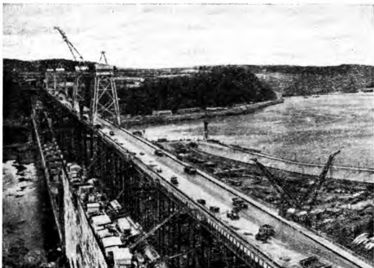
Усть-Илимская ГЭС строится
