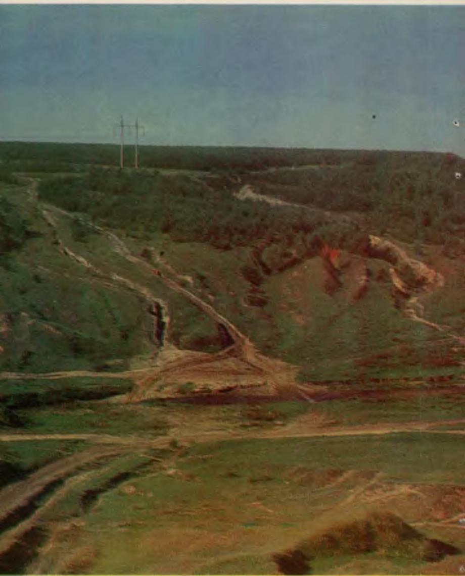
Рис. 8. Проложенные по склону дороги — одна из причин образования оврагов.
