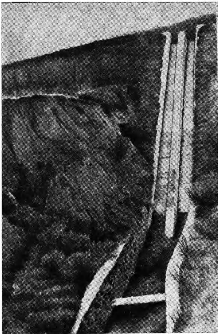
Рис. 25. Спаренный бетонный быстроток предупреждает рост оврага в длину.
