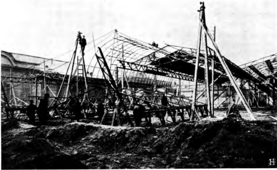
Подъемъ полуциркульныхъ стропиль.
