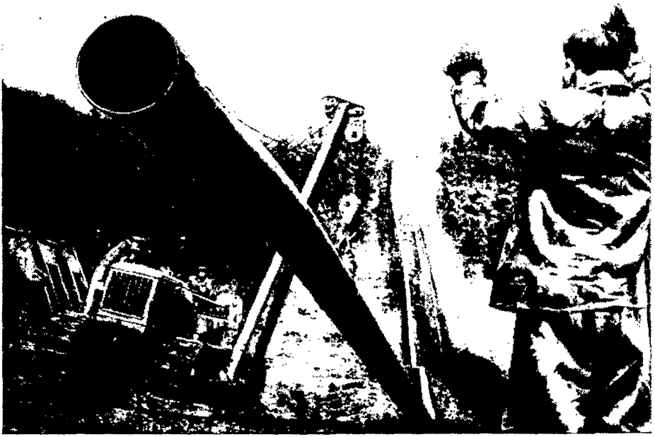
На трассе строительства нефтепровода «Дружба»
