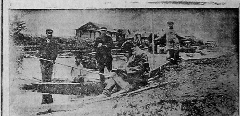
Измерение расхода воды вертушкой на р. Лехма (на переднем плане группа работников).
