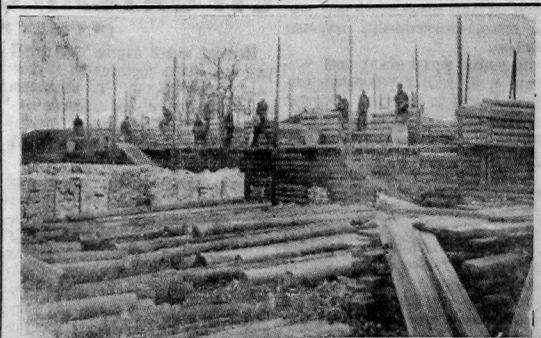
На ул. Герцена строятся три новых дома.
