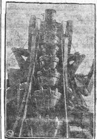
влеченные при помощи землесосов грунты по трубам перегоняются в пониженные места строительства и служат материалом для подъема низин и засыпки болот.
