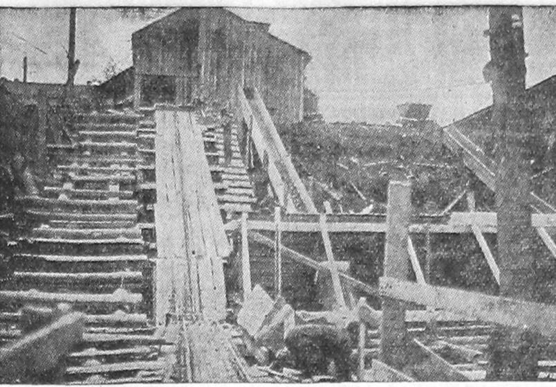
На снимке: бетономешалка выпускает бетон, идущий по желобу в котлован для забивки свайного фундамента берегового устоя.
