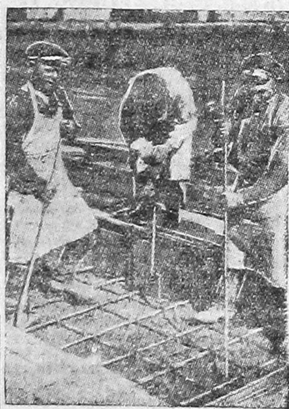
НА СНИМКЕ: бетонировка арматуры правого пролета нового моста через р. Вологду.
