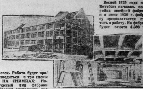
Ремонт. Работа будет производиться в три смены на снимках: Наружный вид фабрики (сверху) и внутренний вид главного корпуса (внизу).
