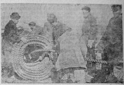
Запавщики за разертыванием «машин» (6 дюймовой снасти) для крепления Вологжской запани.
