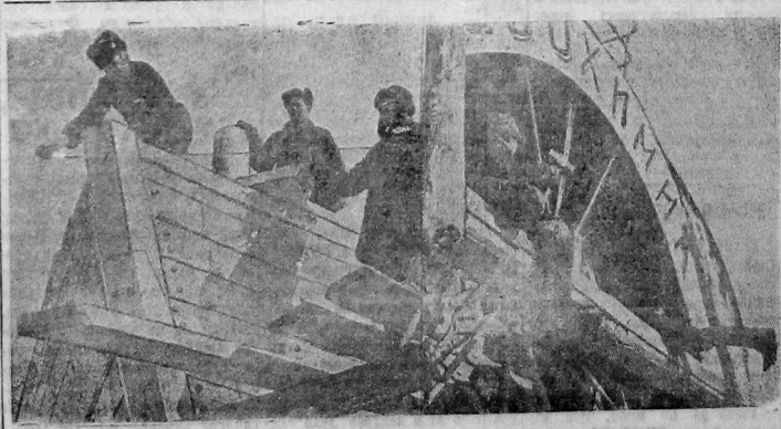
НА СНИМКЕ: Слева мастер тов. КОЗУЛИН за проверкой законченной восстановительным ремонтом баржи № 304. Справа бригада слесарей за сборкой коды парохода «Сельхозснаб».
