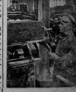
Отделка бревенчаток перед саячей. «СЕВЕРНЫЙ КОММУНАР».
