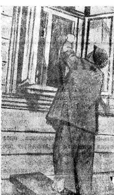
Провели капитальный ремонт помещения детского сада завода «Северный коммунар», шкою первой ступени и ряда квартир рабочих завода. На фото: ударник-рабочий строительной группы «Северного коммунара» тов. В. П. Славное за вставкой стекла.
