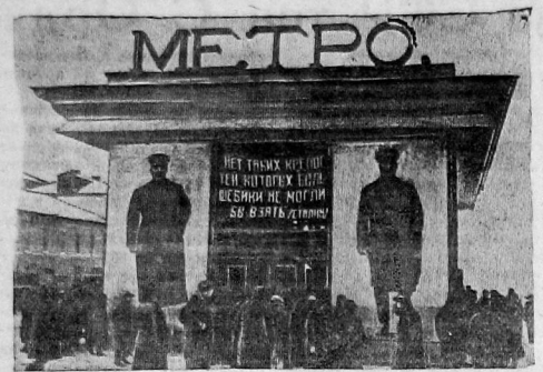
На строительстве лучшего в мире метро. На снимке: здание недавнего вестибюля станции метро «Смоленская площадь», освобожденное от лесов
