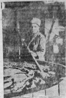
Помощник мастера завода т. А. Голева снимает черный крахмал при обработке в баке.
