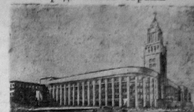
В Выборгском районе Ленинграда идет строительство районного дома советов по проекту архитектора Л. П. Бурмистрова.
