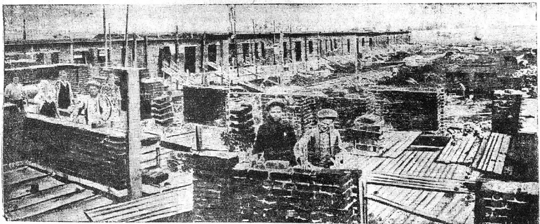
Каменики Тихомиров, Горшков, Мартюничев за кладкой стен пятиэтажного жилого дома на строительной площадке № 3 Вологодского района.
