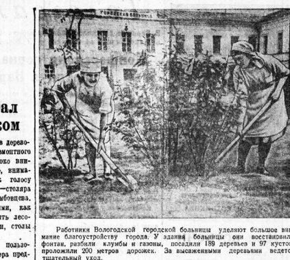
Работники Вологодской городской больницы укладывают большие винтовые блугрунтоустойчивые сваи. У здания больницы они восстановили фундамент, разбили клумбы и дорожки, посадили 189 деревьев и 97 кустов, выкопали 230 метров дренажа. За высаженными деревьями ведется тщательный уход.
