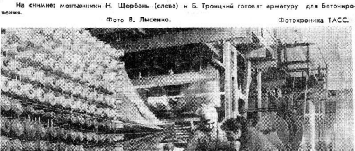
На снимке: монтажники И. Щербак (слева) и Б. Троицкий готовят арматуру для бетонирования...
