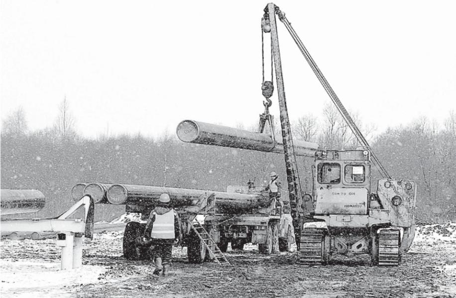
На сегодняшний день завершается прокладка газопровода-отвода протяженностью 119,3 километра диаметром 500 миллиметров.
