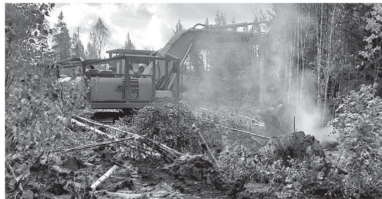
Бульдозеристы и экскаваторщики делают противопожарные разрывы шириной от восьми до 40 метров.
