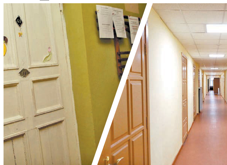
До и после: вот так изменились коридоры в здании общежития после ремонта.
