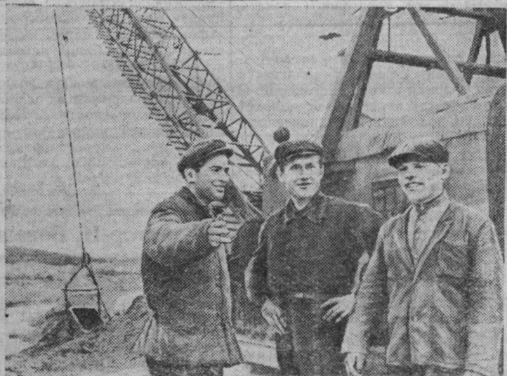
На одном из участков Волго-Балтийского водного пути идёт выемка грунта и прокладка нового русла. Здесь работают шагающие и гусеничные экскаваторы, скреперы, автомашины-самосвалы. Среди строителей идёт добрая слава об экипаже шагающего экскаватора, которым управляет машинист Леонид Ожелевский с помощником Шельмяковым.
