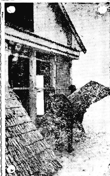
Курганская область. В Камаганском овцеводческом совхозе, расположенном в районе освоения целинных земель, на строительстве жилищ широко используется камень, растущий в окрестностях хозяйства. Из камышитовых плит возводятся стены зданий.
