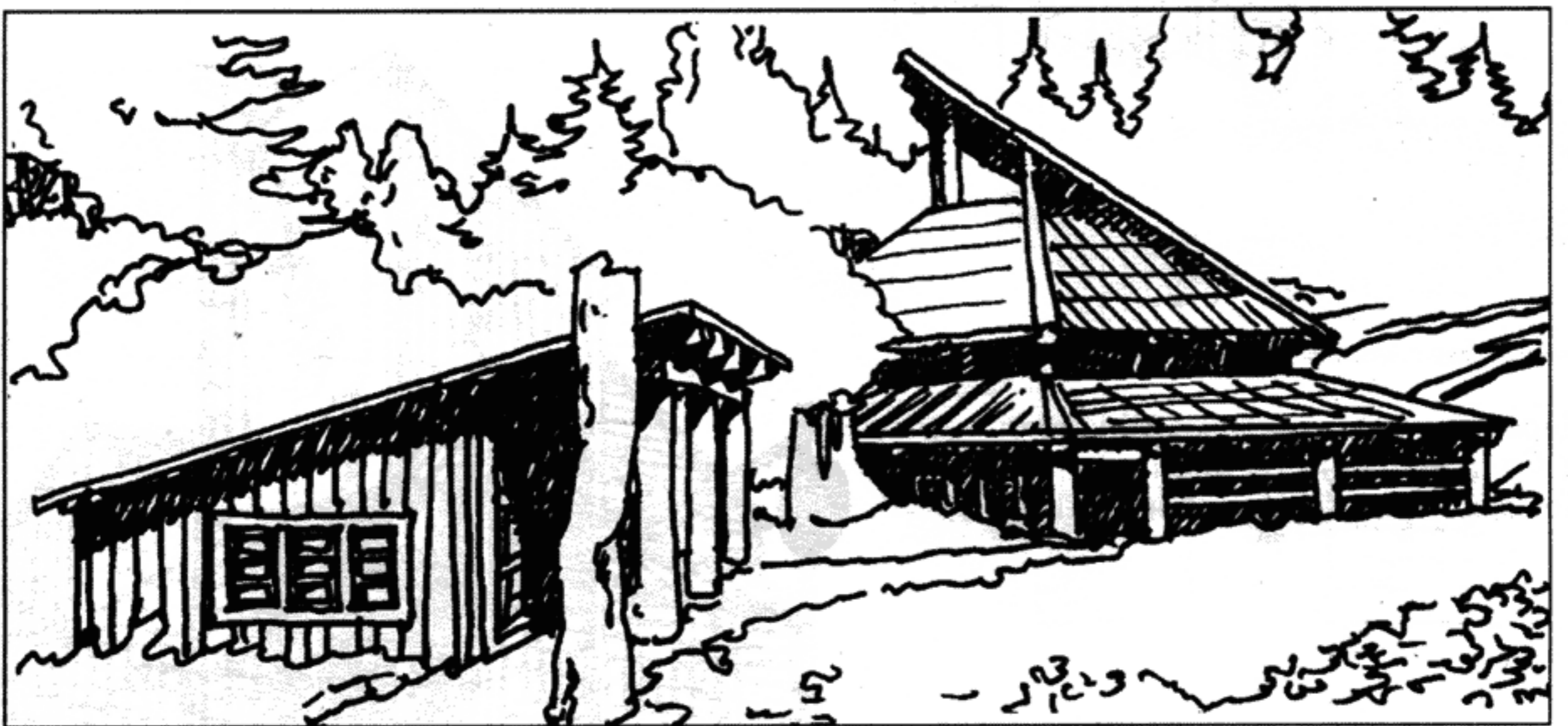
Деревянное здание школы искусств в горной местности (США). 1960 г.
