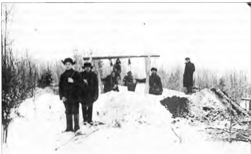
Фото 6. Проходка первого шурфа на Ижинском месторождении пермских глин. Снимок Б.М. Яковцевского. 1934 г. Публикуется впервые
