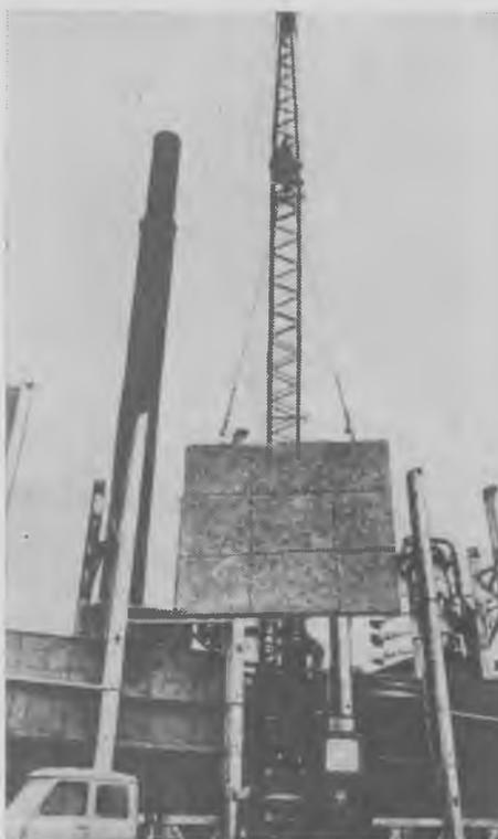
Рис. 1. Монтаж панели из жаростойкого бетона печи нефтеперерабатывающего завода
