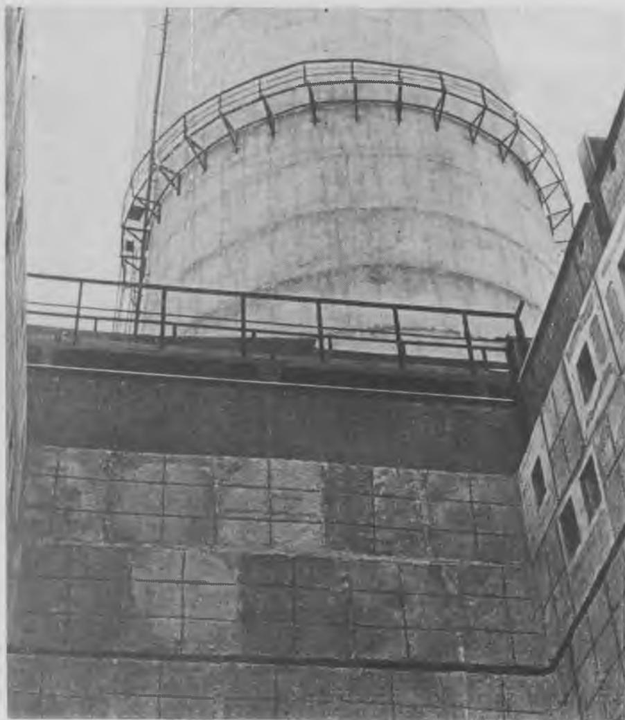
Рис. 3. Общий вид печи установки ЛК-6у из легкого жаростойкого перлитобетона на Павлодарском нефтеперерабатывающем заводе
