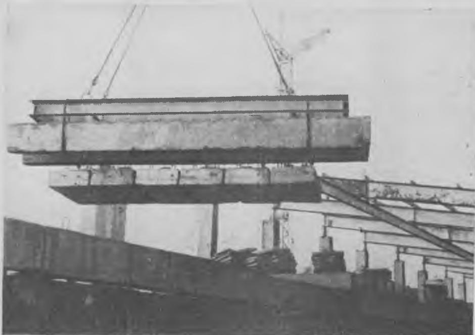
Рис. 2. Монтаж укрупненного узла подвесного свода туннельной печи на Новгородском заводе дренажных труб
