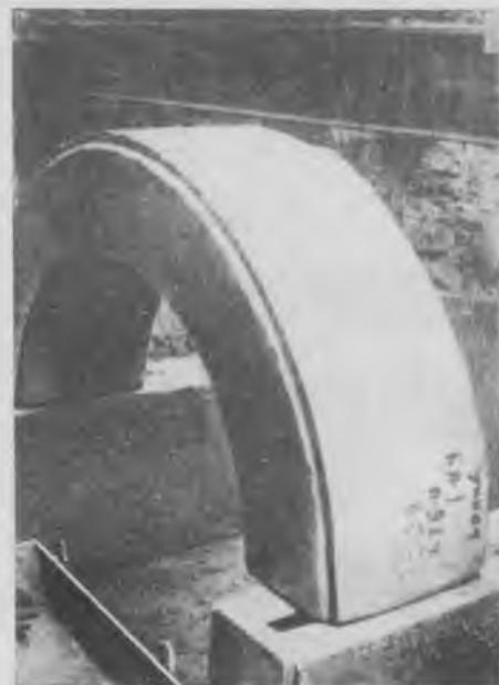
Рис. 3. Монтаж газохода с покрытием из полудирикулярных арок на Новолипецком металлургическом заводе (1979 г.)
