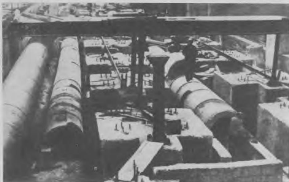
Рис. 1. Общий вид строительства боровов к колпаковым печам из сборного жаростойкого бетона цеха холодного проката Новолипецкого металлургического завода
