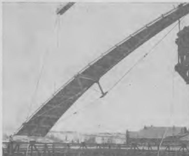
и заделкой в бетон выпусков арматуры меридиональных ребер. Для всех сборных элементов купола, монолитных опорных колец и швов принят бетон марки М300. Купол рассчитан на равномерно распределенную нагрузку  $5 \text{ кН/м}^2$ , ветровую нагрузку со скоростным напором  $0,45 \text{ кН/м}^2$  и сосредоточенную, равную  $15 \text{ кН}$ , приложенную одновременно в восьми точках к поверхности.
