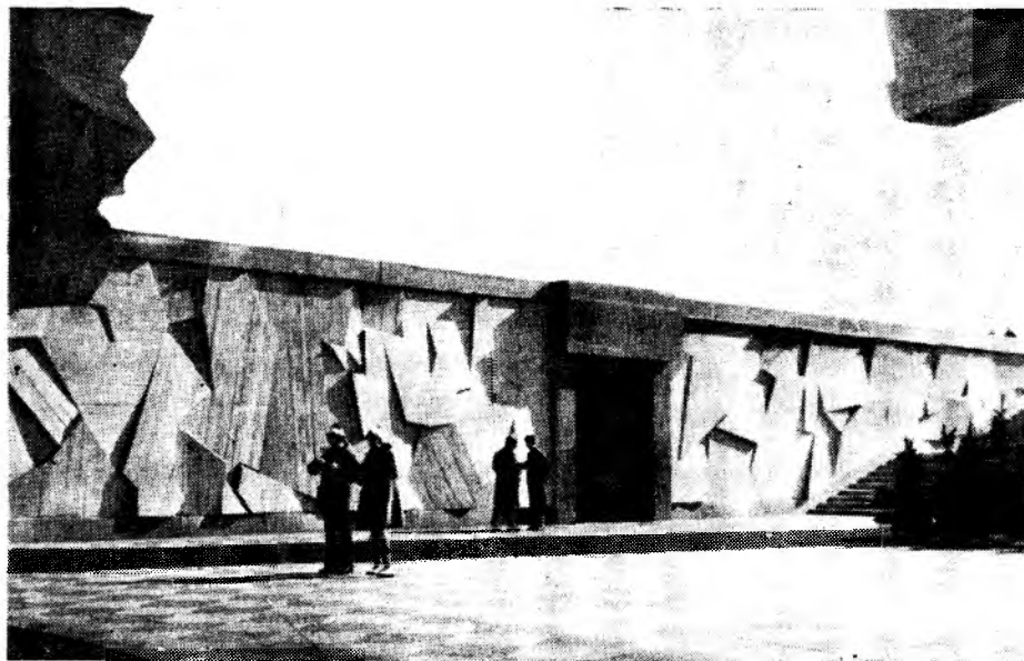
Рис. 4. Фрагмент декоративной облицовки Мемориального комплекса защитникам Ленинграда в годы Великой Отечественной войны. Элементы облицовки выполнены на деревянной матрице
