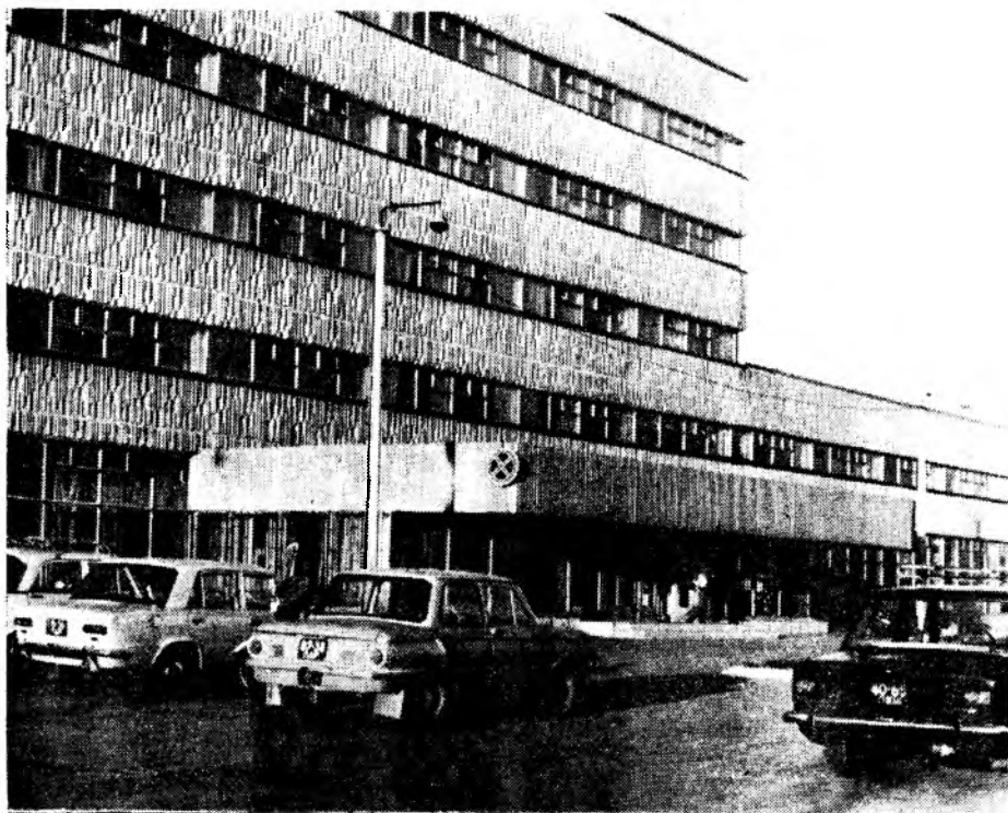
Рис. 6. Административный корпус автопарка № 7. Панели изготовлены на полимербетонной матрице
