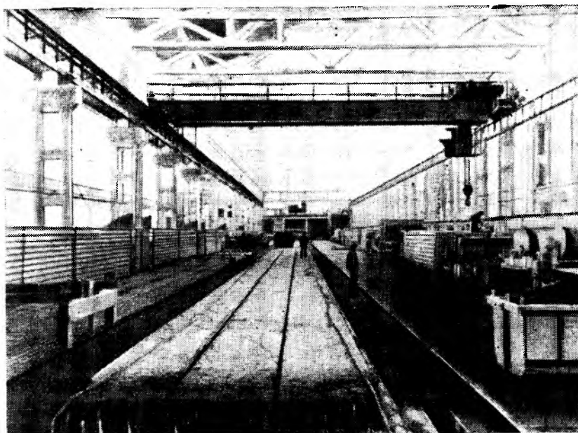
Стенды безопалубочного формования железобетонных конструкций
