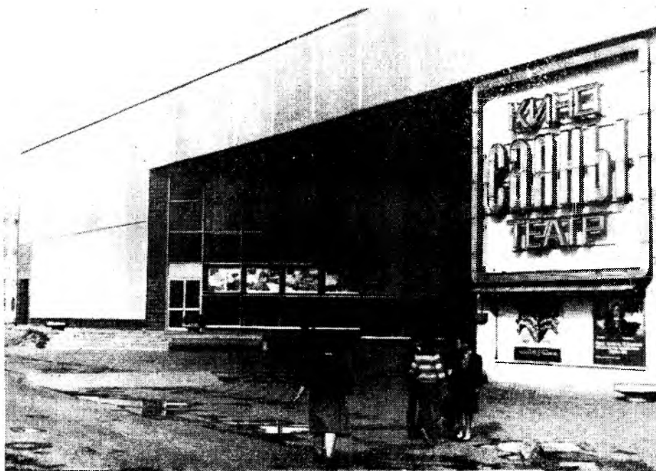
Рис. 2. Фасад кинотеатра, выполненный с применением панелей с рельефной поверхностью
