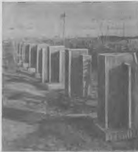
Рис. 2. Монолитные железобетонные фундаменты, возведенные в зимнее время с прогревом бетона в ядре
