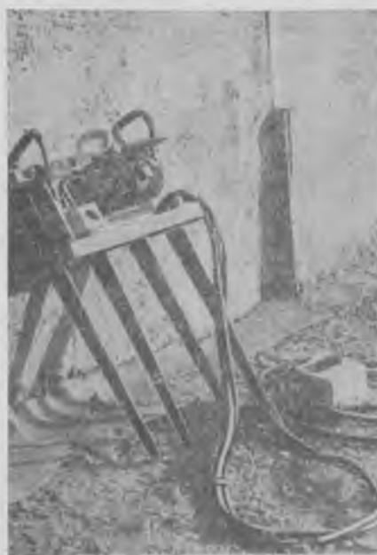
Рис. 1. Устройство для электроразогрева свежесуложенного бетона в полости стыка
