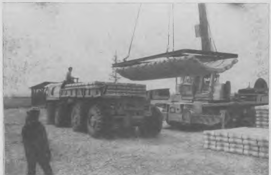
Рис. 2. Изгиб плиты по цепной линии R_{\text{мин}}=2,5 м на строительстве БАМа
