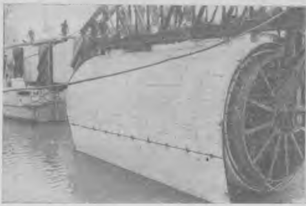
Рис. 3. Укладка покрытия под воду с барабана на р. Дунай
