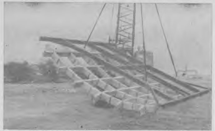
Рис. 4. Блок гибкой решетки подается на откос насыпи моста через р. Днепр в Херсоне
