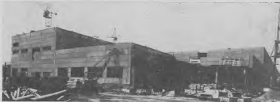
Рис. 3. Строительство плодовоощехранилища с применением в наружных стенах и перегородках холодильных камер трехслойных панелей из легкого бетона с эффективным утеплителем и гибкими связями
