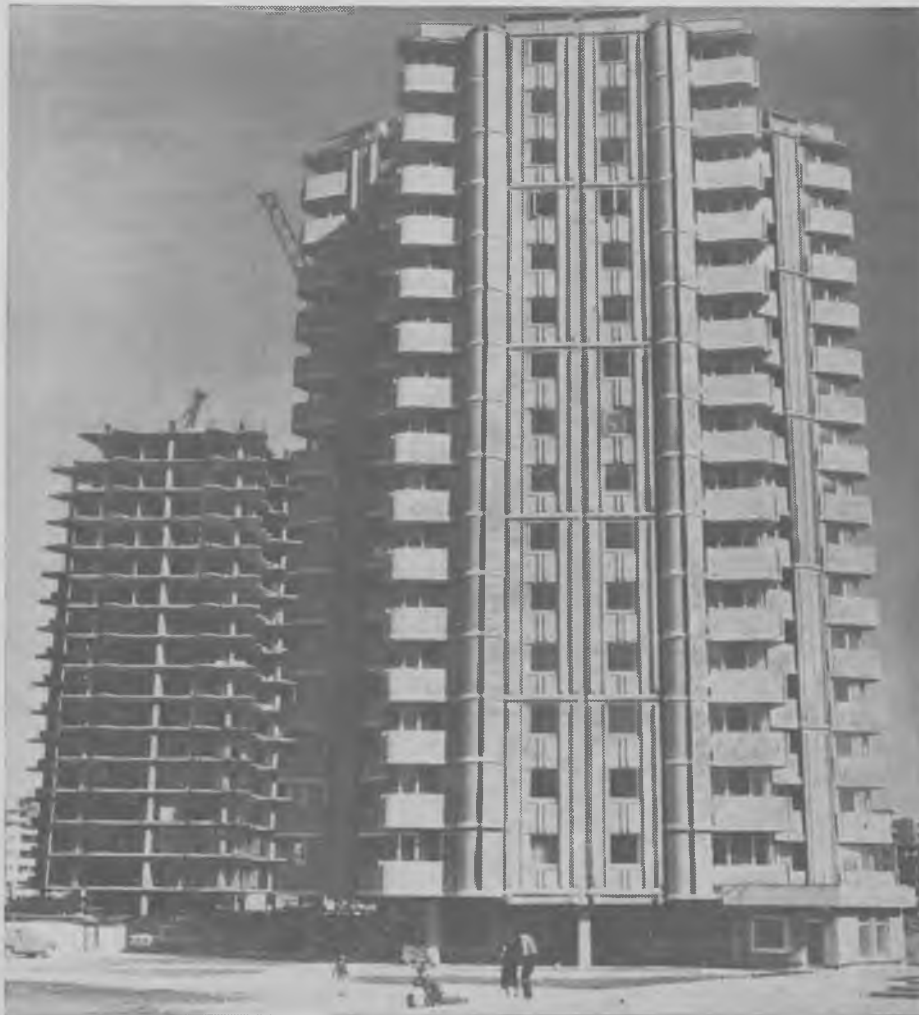
Рис. 4. 16-этажные жилые дома с подъемными перекрытиями из керамзитобетона в Каунасе
