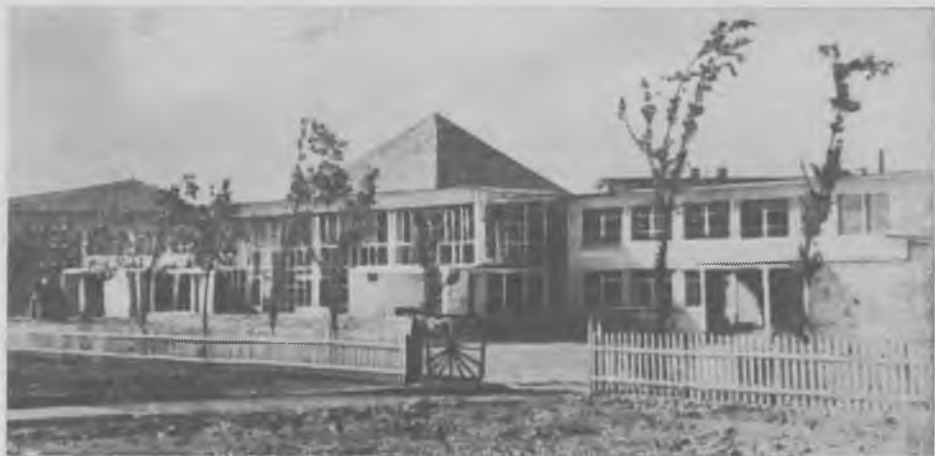
Рис. 2. Здание детского сада из шлакобетона
