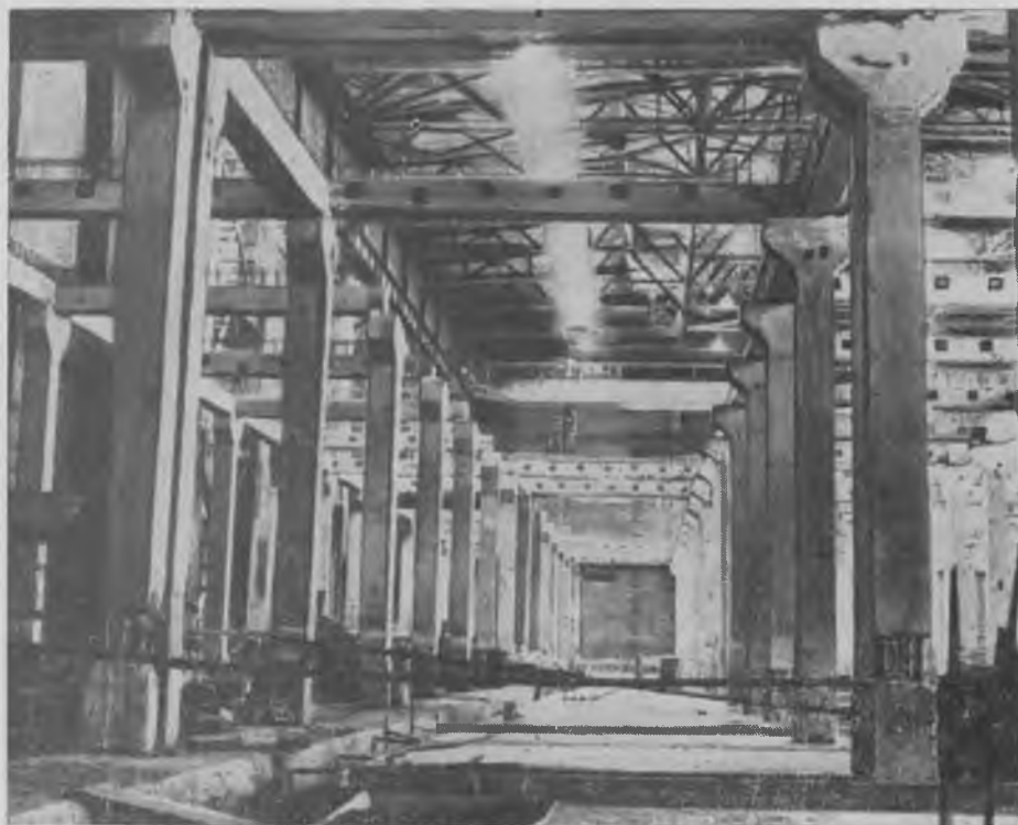
Рис. 2. Железобетонные конструкции технологической эстажерки из кислотостойкого бетона в цехе медных порошков комбината Уралэлектромедь
