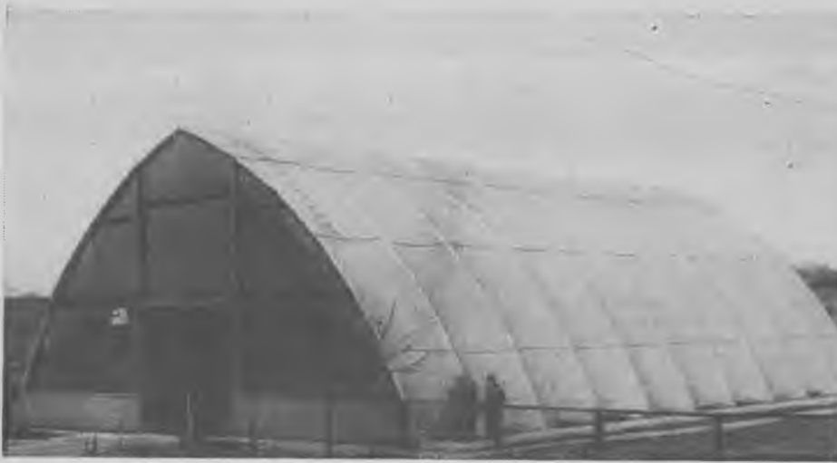
Рис. 4. Сводчатое здание из железобетонных панелей-оболочек двойной кривизны
