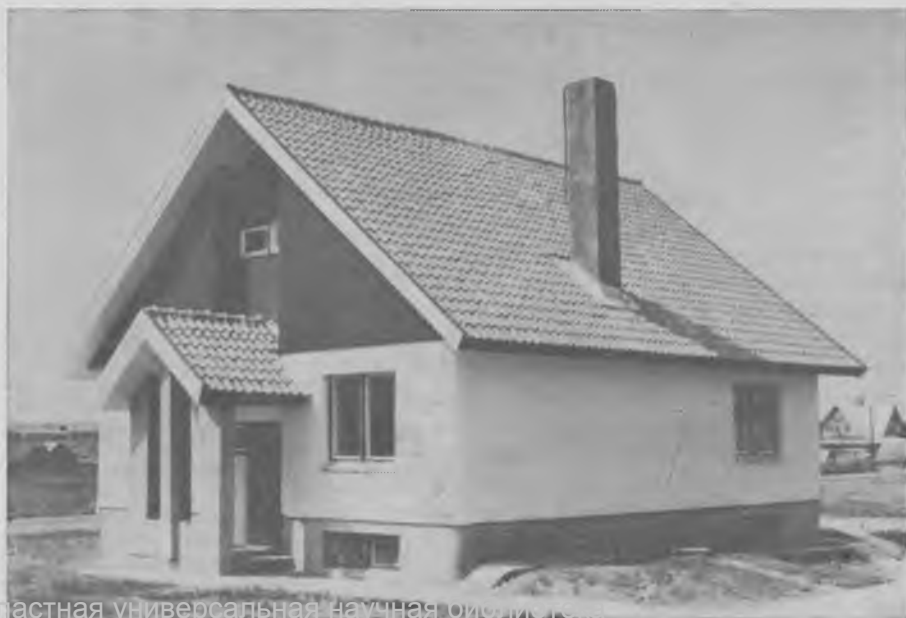
Рис. 2. Усадебный монолитный дом из керамзитобетона в Палукне (Тракайского р-на ЛитССР)
