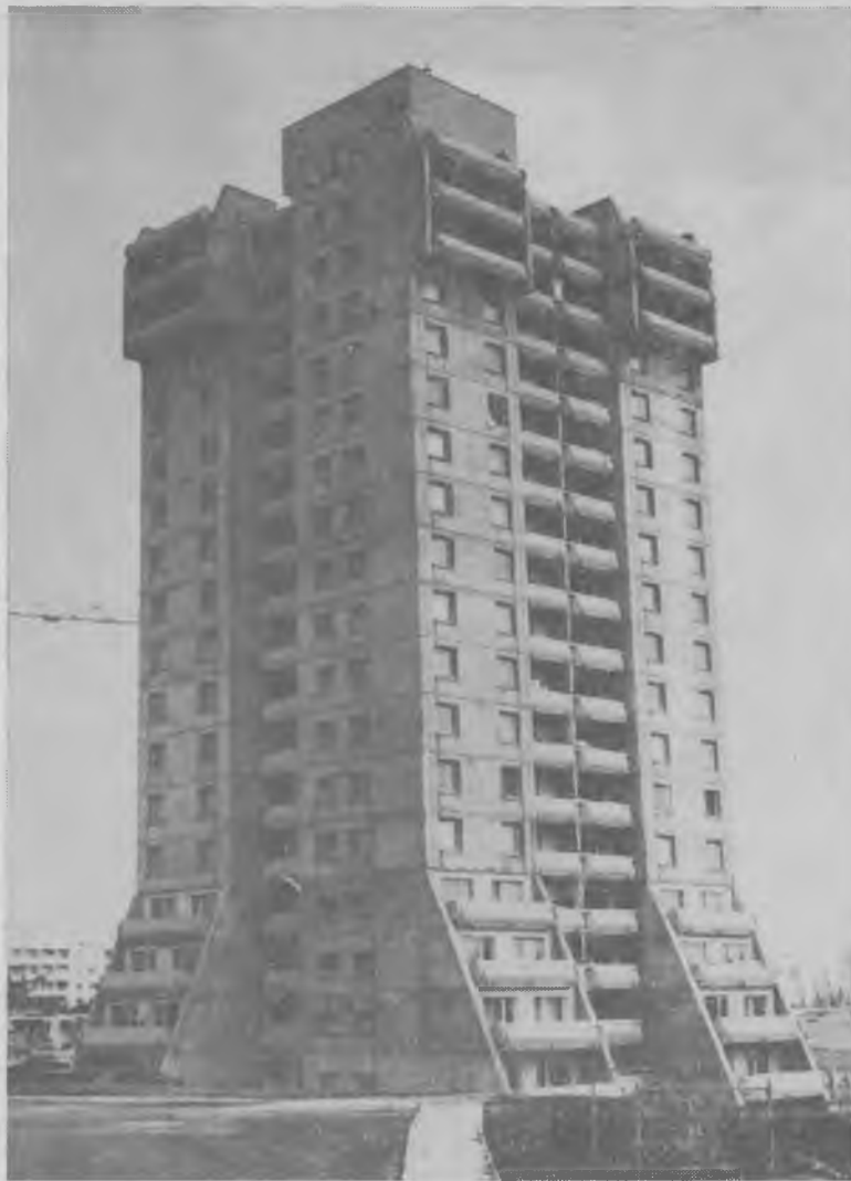
Рис. 1. 16-этажный монолитный жилой дом из керамзитобетона в Вильнюсе
