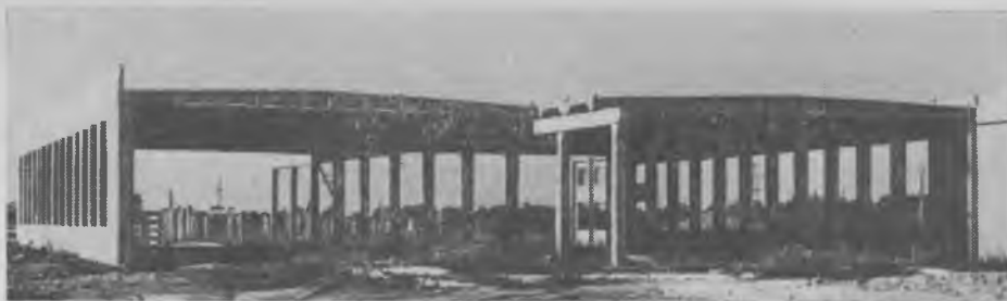
Рис. 2. Строительство двухпролетного промышленного здания с неполным каркасом с использованием наружных стеновых панелей из легкого бетона как несущих конструкций
