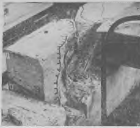
Рис. 3. Характер разрушения опорной зоны ригеля при кручении по схеме 2
