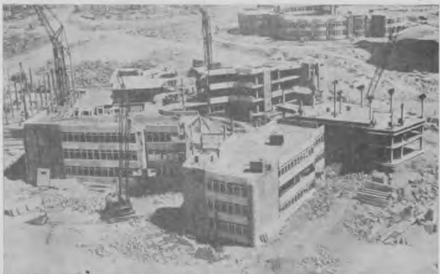
Рис. 3. Возведение методом подъема многоэтажного каркаса здания школы. На заднем плане возведенное методом подъема здание детского сада
