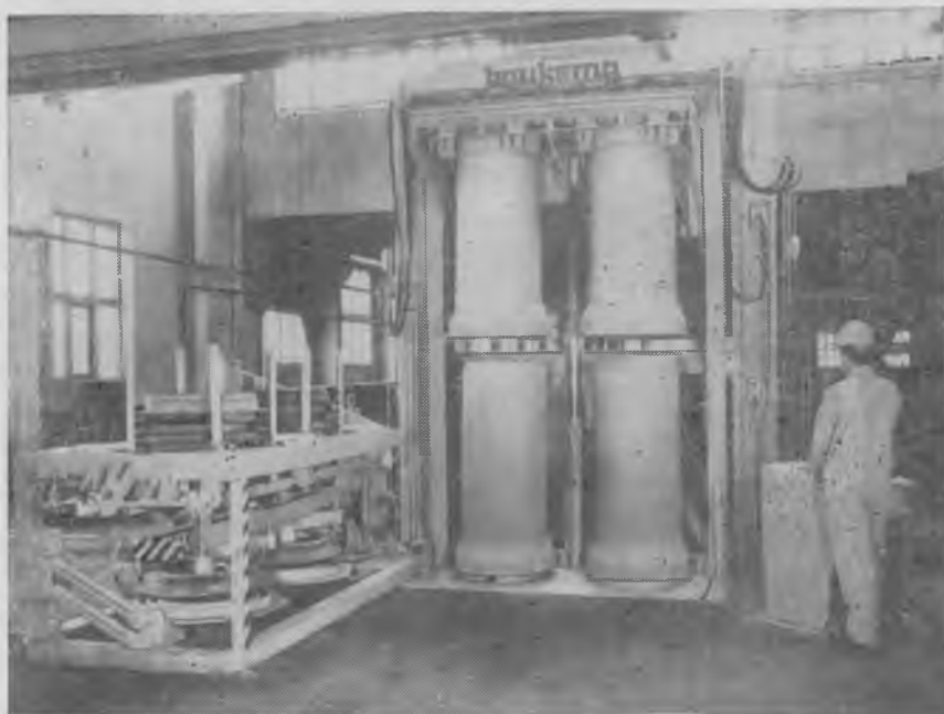
Рис. 3. Линия для производства бетонных элементов В 1,5
