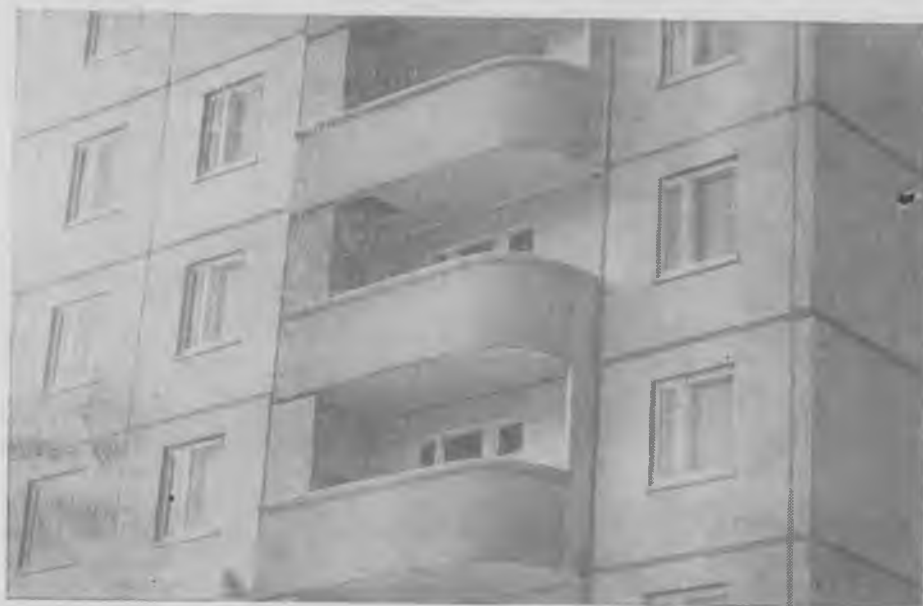
Рис. 1. Экраны лоджий домов серии 111-97
