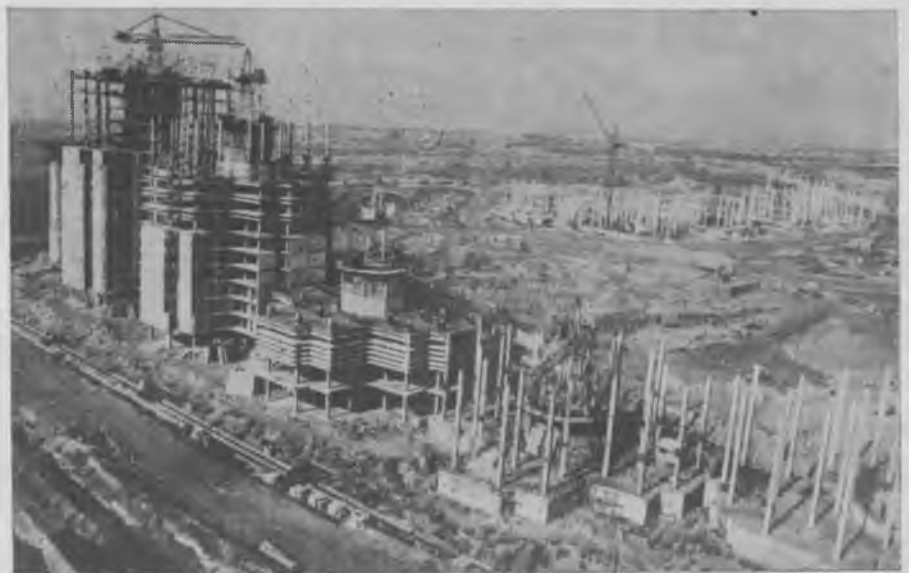
Рис. 1. Поточное строительство методом подъема 16-этажных жилых домов в Ереване
