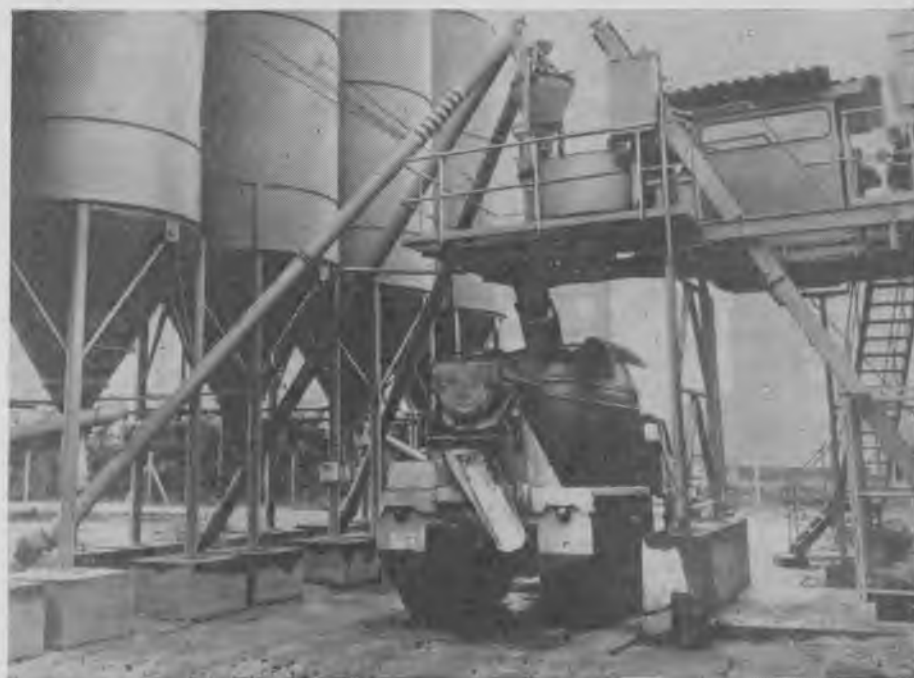
Рис. 2. Выгрузка свежего бетона из установки БА 500 Б
