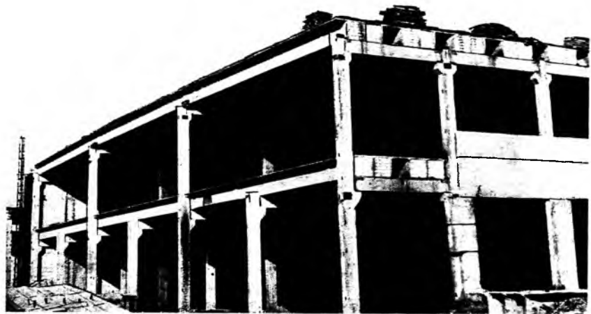
Рис. 1. Строительство двухэтажного производственного здания с 18-метровыми коробчатыми настилами-воздуховодами (Брест)
