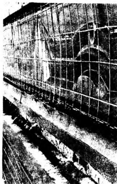
**Рис. 5.** Подготовленные к бетонированию армированные формы ограждений лоджий с установленными в них полимербетонными матрицами
