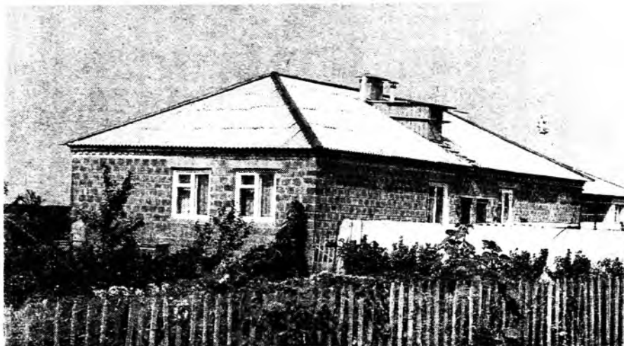
Рис. 2. Двухквартирный дом усадебного типа из мелких неавтоклавных блоков (пос. «Стрелецкий заповедник» Курской обл.)
