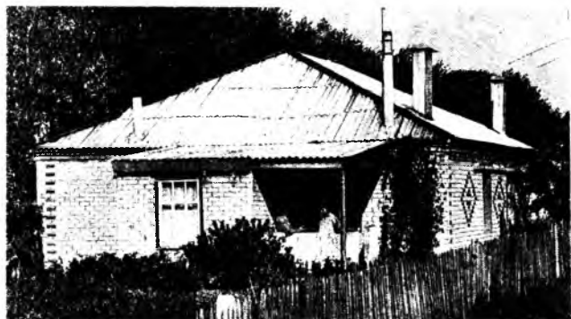
Рис. 4. Двухквартирный дом усадебного типа с наружными стенами из мелких пенозолобетонных блоков, облицованных силикатным кирпичом (пос. «Стрелецкий заповедник»)
