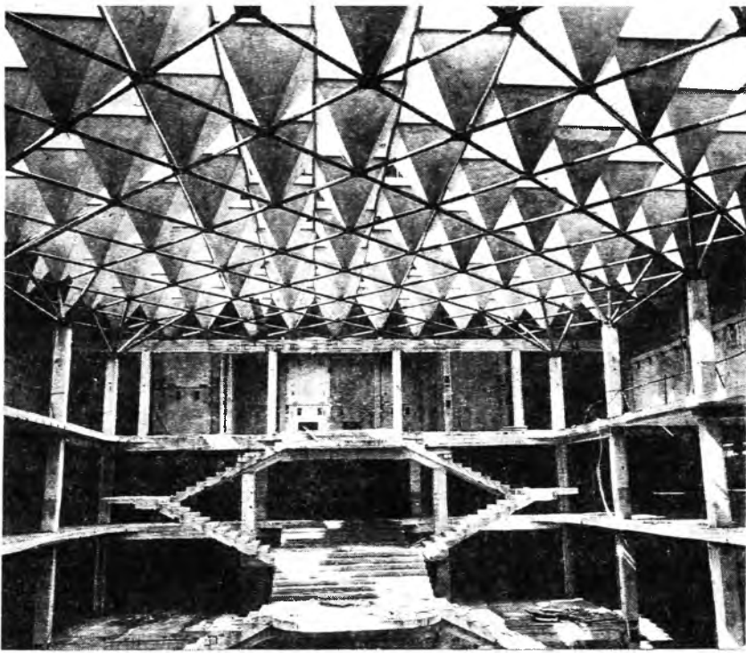
Рис. 3. Покрытие зала публичной библиотеки в Санкт-Петербурге армоцементной структурной конструкцией с металлическим нижним поясом
