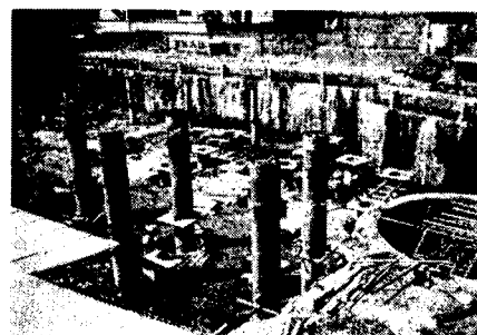
Рис. 2. Процесс возведения подземной части трубобетонных колонн здания Peace World Plaza методом обратного хода
