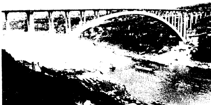
Рис. 6. Вансянь мост (г.Чунцин) шириной 24 м пролетом 420 м через р.Янцзы
