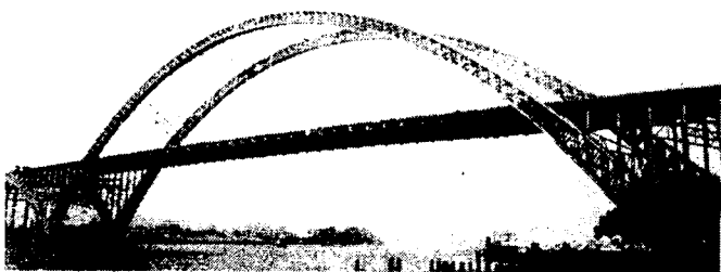
Рис. 8. Яцзиша мост шириной 36,5 м с пролетами 76+360+76 через р.Чжу в г.Гуанчжоу
