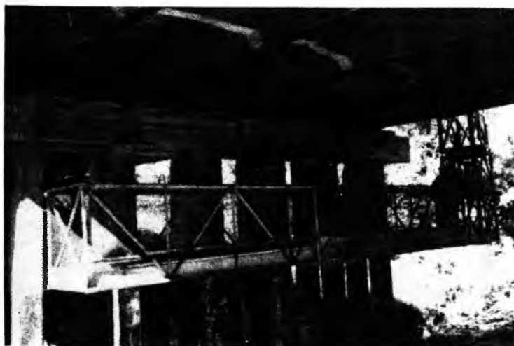
Рис.6. Пролетное строение моста через р.Кехта после ремонта и усиления (видны полосы из углепластика)
