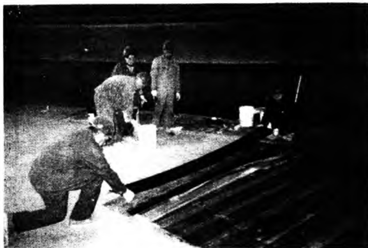
Рис. 4. Усиление чаши сгустителя (наклейка лент из углеродной ткани в зоне кольцевой балки)
