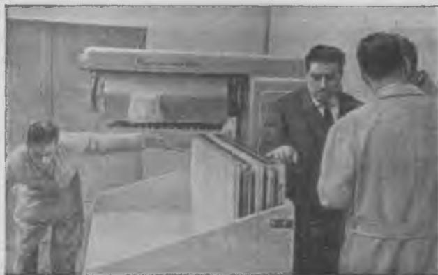
Рис. 16. Установка щитов на столе однобарабанного полировального станка для полирования кромок
