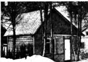
Рис. 1. Садовый домик из прессованного конструкционного бруса
